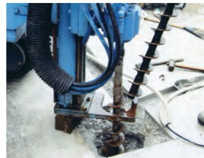
タンク、配管周りの電極を設ける位置にボーリングします。
