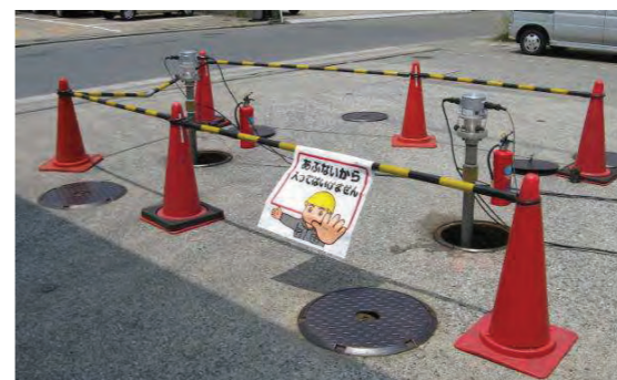
配管・地下タンクの加圧検査
