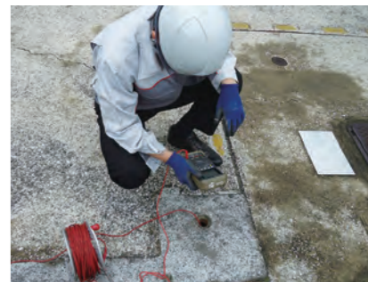
配管・タンクの電位を測定し、防食状態に調整します。
