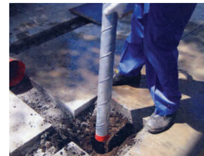
ボーリングした孔の中に電極を埋設固定します。
