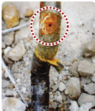
■ 配管の孔あき腐食
