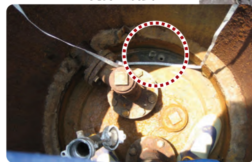
■ マンホール内部の腐食
