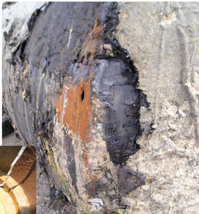
■ 穴のあいた地下タンク
