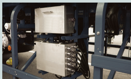
④ 荷卸操作盤
