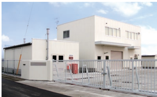
建物の設計・施工【屋内貯蔵所(左) 事務所(右)】
